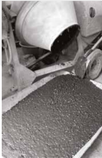
Figura 3. Mezcla de concreto hidráulico con ceniza de bagazo de caña como sustituto parcial del cemento Portland. Se observa una coloración más oscura por acción de la ceniza.
