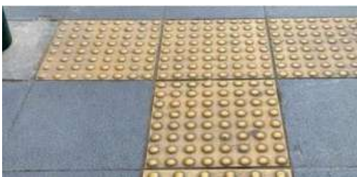
Figura 3. Suelo con señales podotáctiles, las líneas paralelas indican la dirección del recorrido y los puntos indican inicio y fin de un recorrido, cambio de dirección o nivel y zonas de alerta o peligro. Fuente: https://www.inci.gov.co/blog/guiapodotactil-para-ciegos
