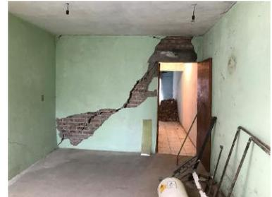
Figura 2. Agrietamiento en muros de carga de casa habitación provocadas por la Falla Centro. Sector centro-este de Zamora.
