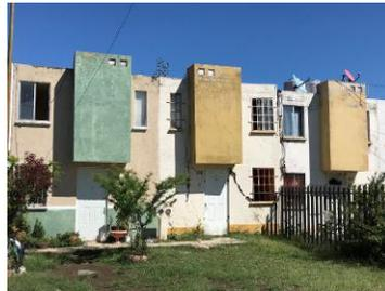
Figura 1. Agrietamiento de fachadas provocadas por la Falla Campestre. Sector NE de Zamora.
